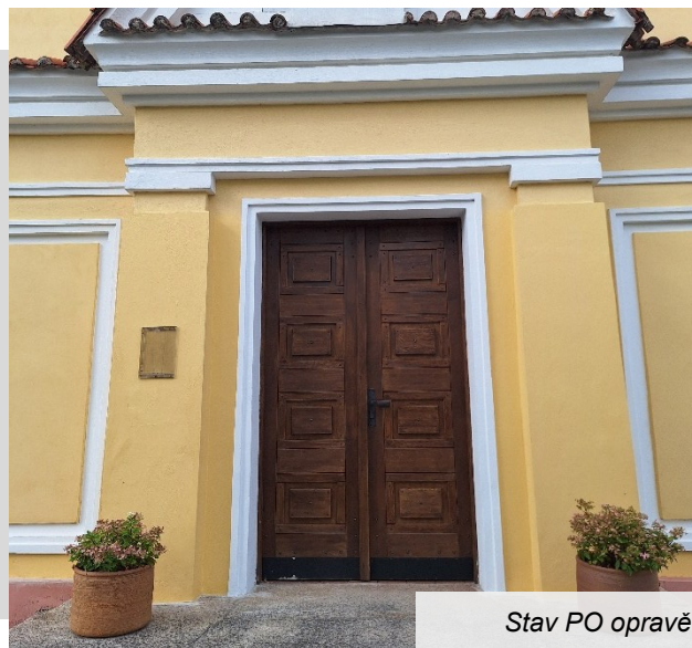
Stav PŘED opravou
