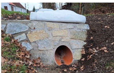
Propustek V PRŮBĚHU rekonstrukce
