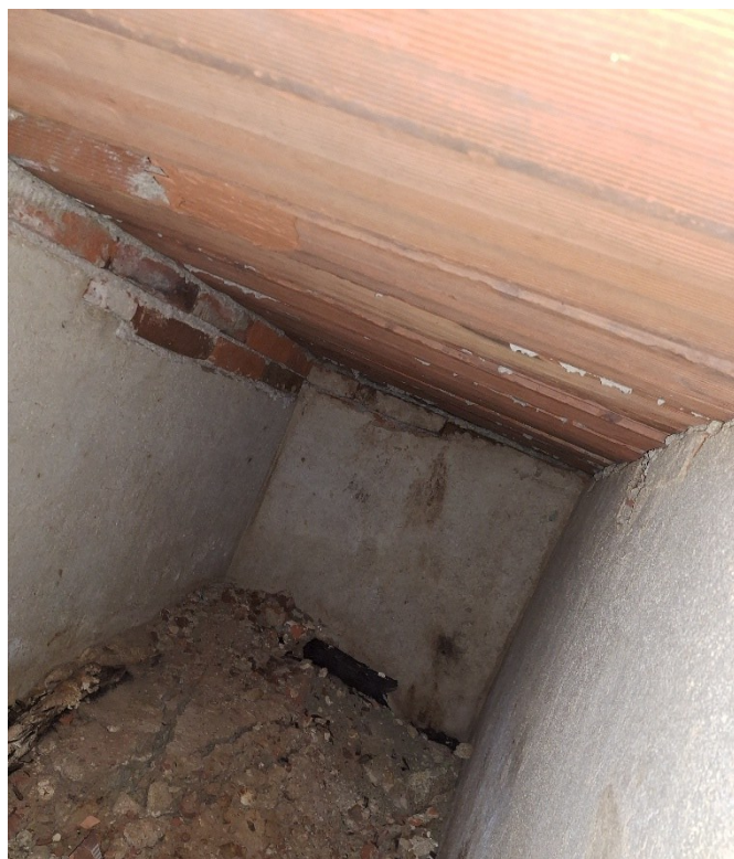
Náhled otvorem v podlaze do krypty, v níž byla uložena těla zesnulých Schwarzenbergů, strop této krypty je vytvořen novodobě z hurdišů
