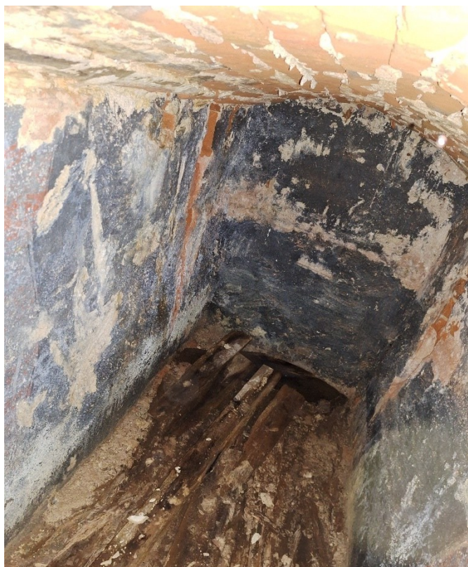
Náhled otvorem v podlaze do krypty, v níž byla uložena těla zesnulých Schwarzenbergů, strop krypty tvoří klenba
