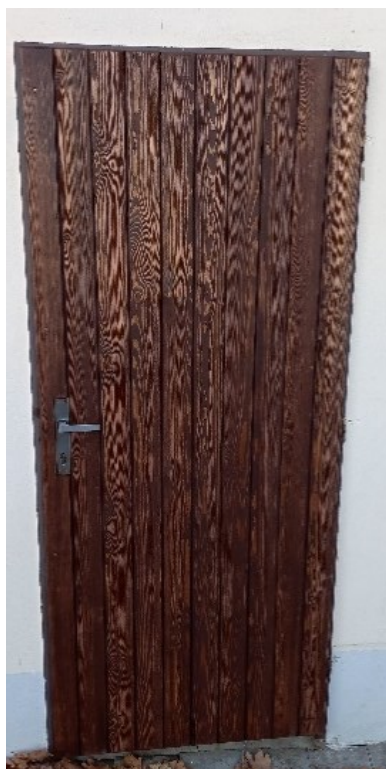
Stav po opravě
