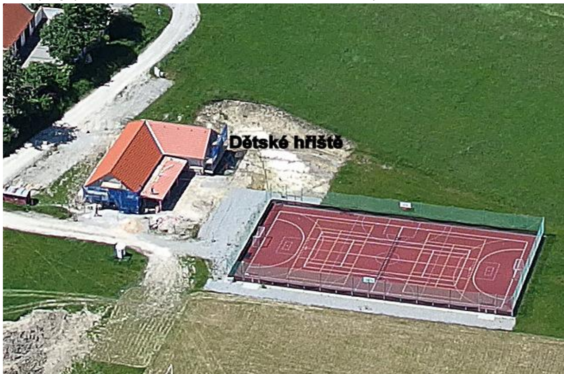
Letecká fotografie, zleva dokončovaná hasičárna, budoucí dětské hřiště a stávající víceúčelové hřiště.
